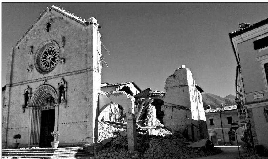
Рис. 2. Последствия разрушительного землетрясения в городе Норчия 30 октября 2016 г.
