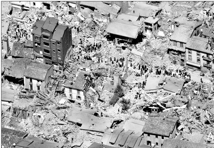
Рис. 1. Разрушения зданий исторической части города Аматриче после землетрясения 24 августа 2016 г.
